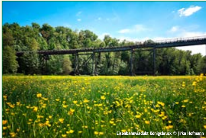
Eisenbahnviadukt Königsbrück © Jirka Hofmann
